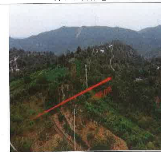
跨越 10 千伏线路
