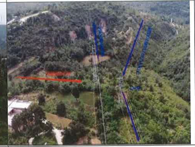
110 千伏江岭T 接春北线路42#杆塔
